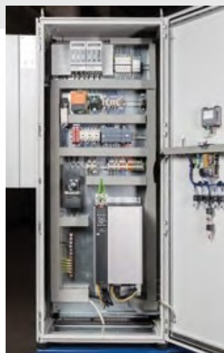
Електрошкаф с преобразувател на честота
